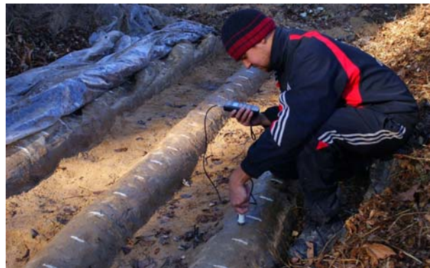
Рис. 3. Вимірювання твердості ґрунтоцементу приладом «Онікс-2,5»
