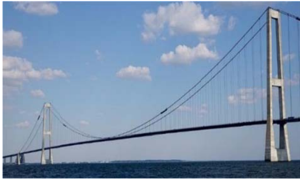
Рис. 1. Главный пролет моста Большой Белт Восточный
