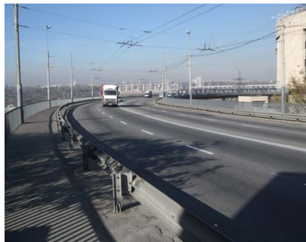
Рис. 1. Общий вид проезжей части эстакады
