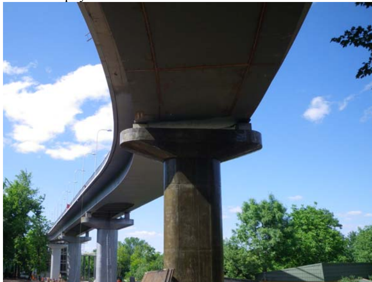
Рис.2. Загальний вигляд естакади.
