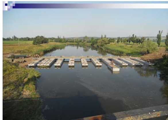
Рис. 3. Наведення наплавного моста НЖМ-56 на обході зруйнованого моста
