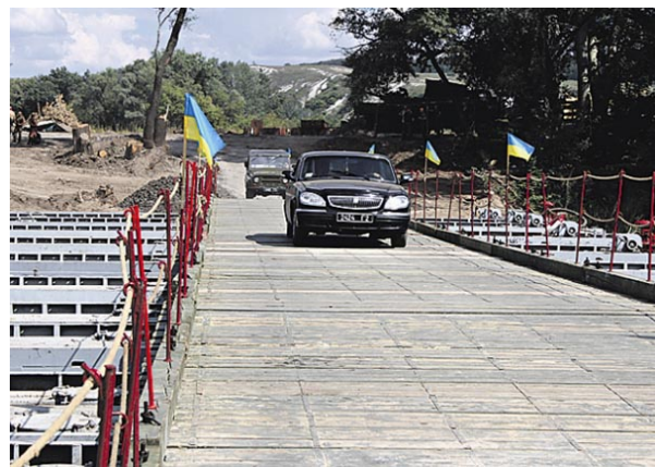
Рис. 4. В обхід зруйнованого моста наведено переправу НЖМ-56.
