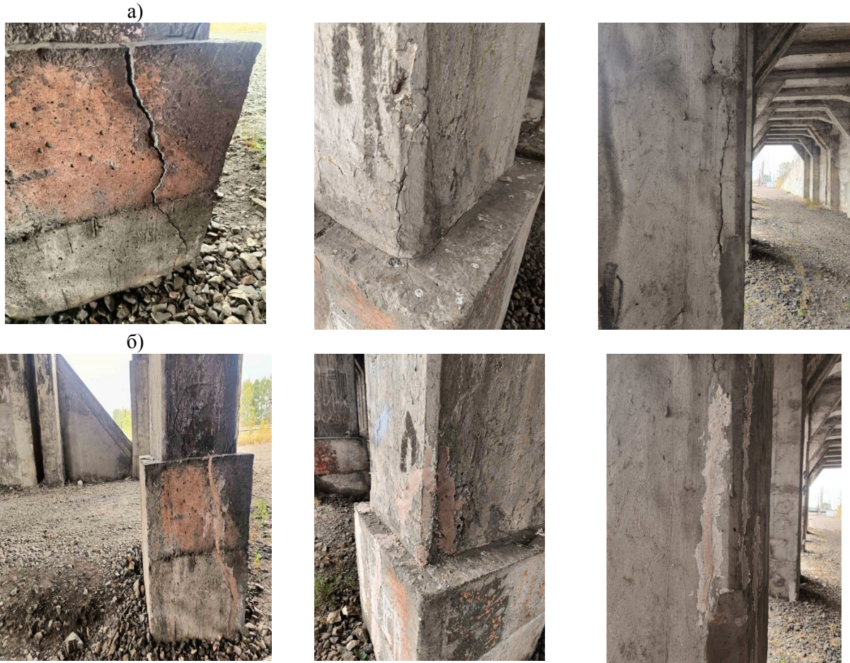
Рис. 4. Фото частин опори мосту до (а) і після (б) ремонту
