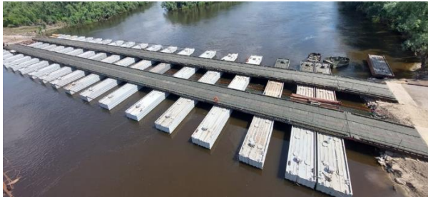
Рис. 6. Автостроїний наплавний міст НЖМ-56 через р. Десна біля м. Чернігів
