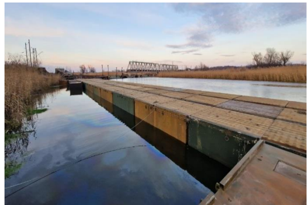
Рис. 9. Понтонна переправа Ponton 100 через р. Оскіл в Харківській обл.
