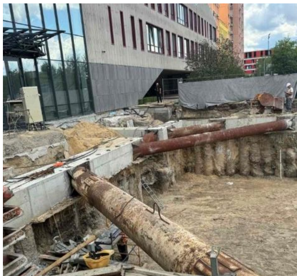
Рис. 7. Використання струменевої цементациї ґрунтів для огороження котловану (2024)
