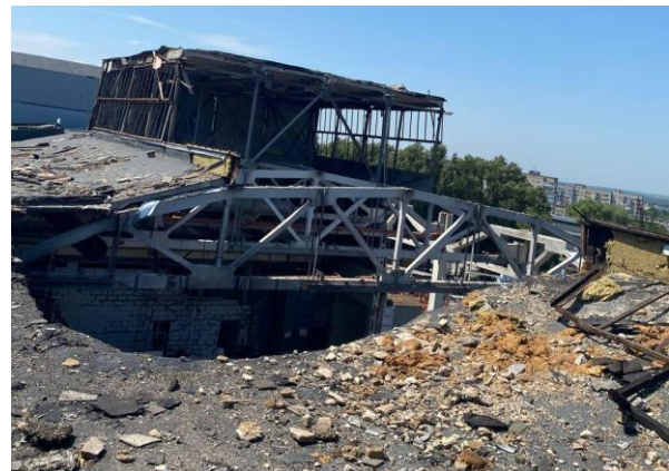
Рис. 3. Зона повного руйнування покриття внаслідок влучання ракети між рядами "Т"- "У" та осями "3"- "10"; рядами "Р"- "Т" та осями "5"- "9"; рядами "П"- "Р" та осями "6"- "8"
