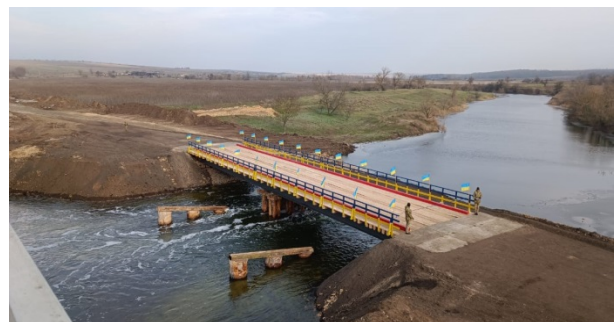
Рис. 8. Тимчасовий міст на ближньому обході
