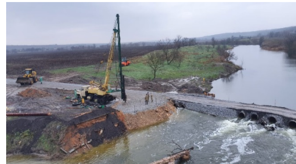
Рис. 7. Тимчасова переправа з водопропускних труб
