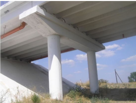
Рис. 5. Загальний вигляд проміжної опори №2
