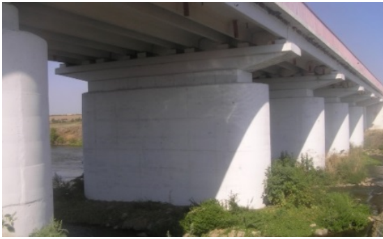
Рис. 4. Загальний вигляд проміжних опор № 3-№ 7
