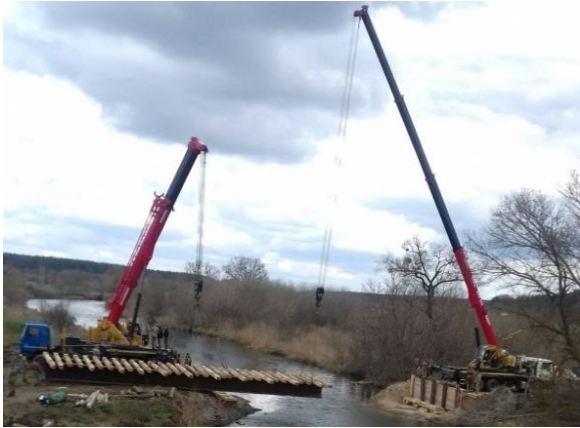
Рис. 8. Монтаж прогонових будов
