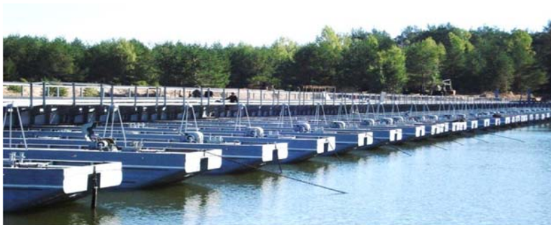
Рис. 7. Загальний вигляд руслової частини наплавного мосту
