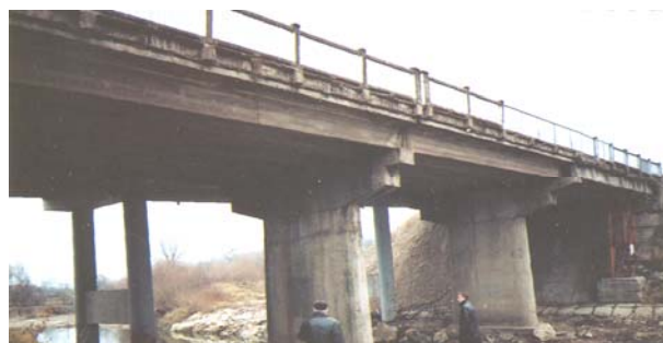
Рис. 2. Загальний вид існуючого моста
