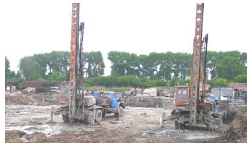
Рис. 2. Влаштування вертикальних ґрунтоцементних елементів на майданчику будівництва
