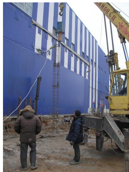
Рис. 8. Осадження арматурного каркасу електровібратором
