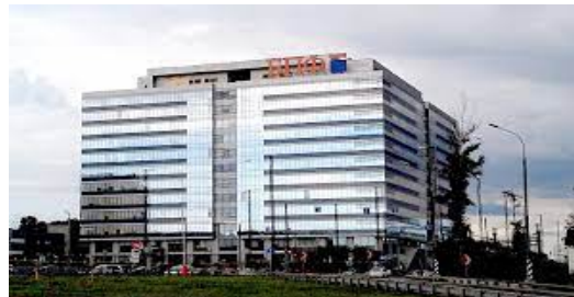
Рис. 6. Офісний центр «Кубік»
