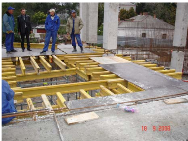
Рис. 5. Установка опалубки ригелей
