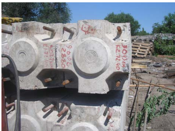
Рис. 1. Выпуски арматуры в торцах колон для их сочленения в процессе монтажа
