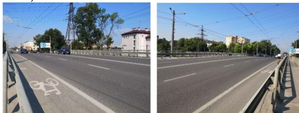
Рис. 4. Загальний вид реконструйованого шляхопроводу (а) та вид на мостове полотно (б)
