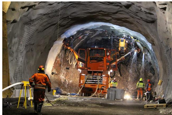
Рис. 3. Цементация масиву, Vadlaheidi road tunnel, Ісландія (фото з Reynolds, 2016)
