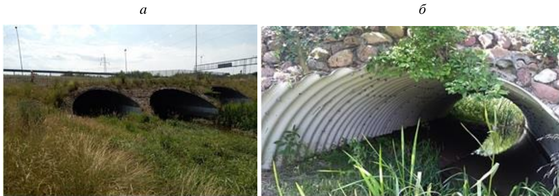
Рис. 5. Обстеження споруд із МГК (Польща): а) триотворна арочна труба; б) труба замкнутого контуру із плоскою основою
