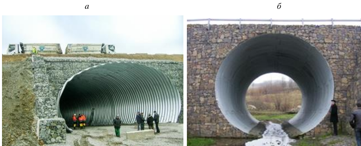
Рис. 2. Шляхопровід із металевих гофрованих конструкцій: на км 228+160 автомобільної дороги Київ – Харків – Довжанський (а) (Компанія ViaCon); труба із МГК на ділянці Вадул – Сирет – Держжордон Львівської залізниці (б)
