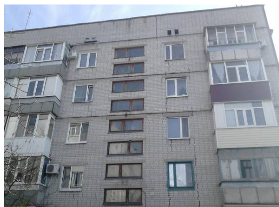
Рис. 1. Вигляд торцевої блок-секції деформованої будівлі (в період підготовчого періоду геотехнічного моніторингу)
