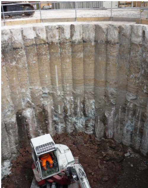
Рис. 2. Вертикальна виробка при закріпленні ґрунту технологією «стіна в ґрунті»
