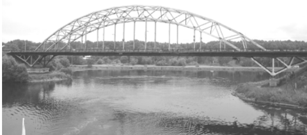
Рис. 7. Никольский мост в г. Кинешма
