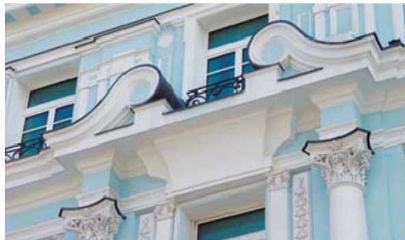
Рис. 1. Защита элементов фасада
